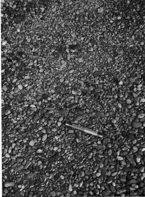
Abb. 2: Feinmaterialzentren neben Verwirbelungen in homogenem Grobmaterial (Steinrosetten). Standort: Flachdach eines Hochhauses, Maßstab: Zollstock, Datum der Aufnahme: 25. 10. 1976.)
