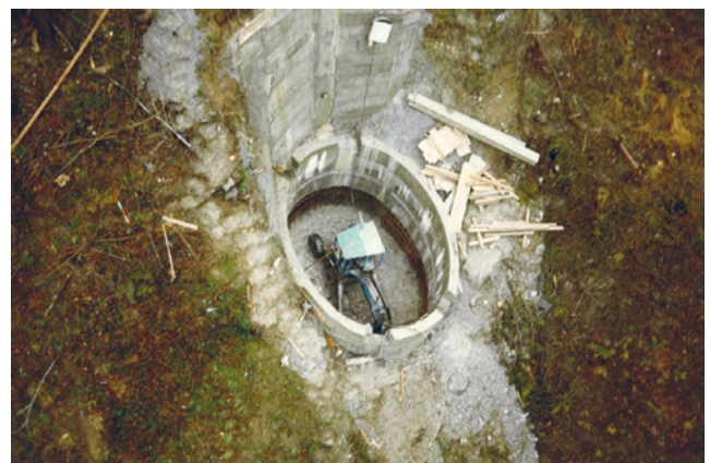
Abb. 2: Aushub eines Gründungsschutzschachtes mit einem elektrisch betriebenen Schreitbagger. Foto: J. Gasser, April 1980.
